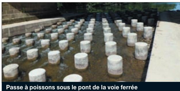
Passe à poissons sous le pont de la voie ferrée
