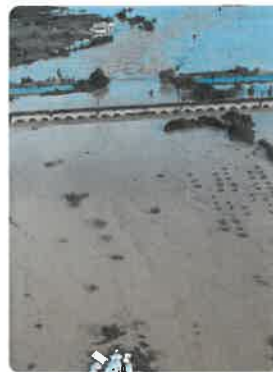
Gallargues-le-Montueux - Crue de la plaine - Inondation de septembre 2002
