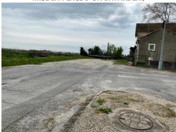
FIGURE 42 : PRESENCE DE NOMBREUX RESEAUX AU CROISEMENT ENTRE LA VOIE FERREE ET L'AVENUE DE LA GARE
