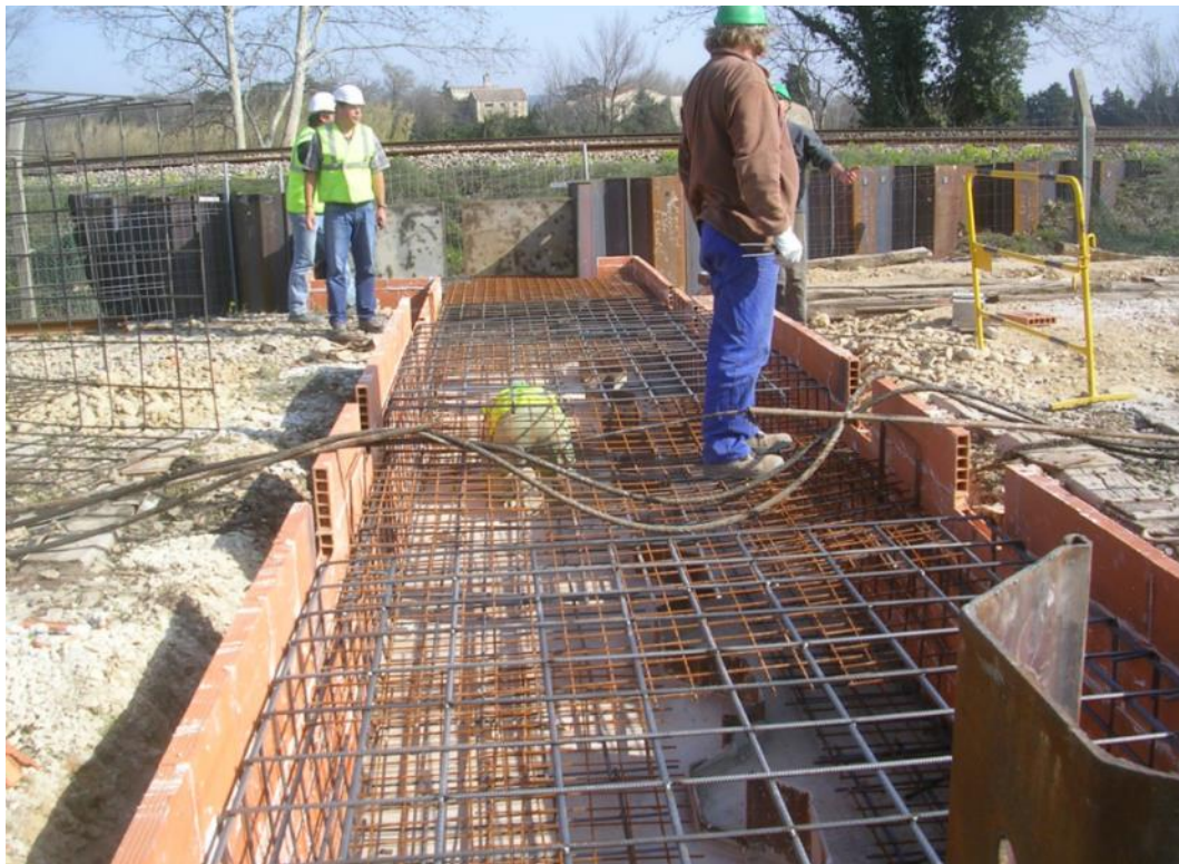
FIGURE 55 : REALISATION DE LA FONDATION BETON D'UN BATARDEAU AMOVIBLE SUR UNE VOIE FERREE A TARASCON (EGIS, 2014)
