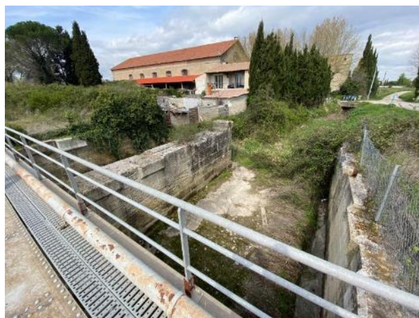
FIGURE 39 : OUVRAGE HYDRAULIQUE TRAVERSANT LA VOIE FERREE
