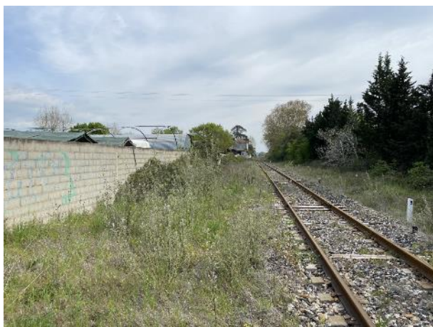
FIGURE 38 : FAIBLE ESPACE DISPONIBLE POUR LA MISE EN PLACE DU SYSTEME D'ENDIGUEMENT
