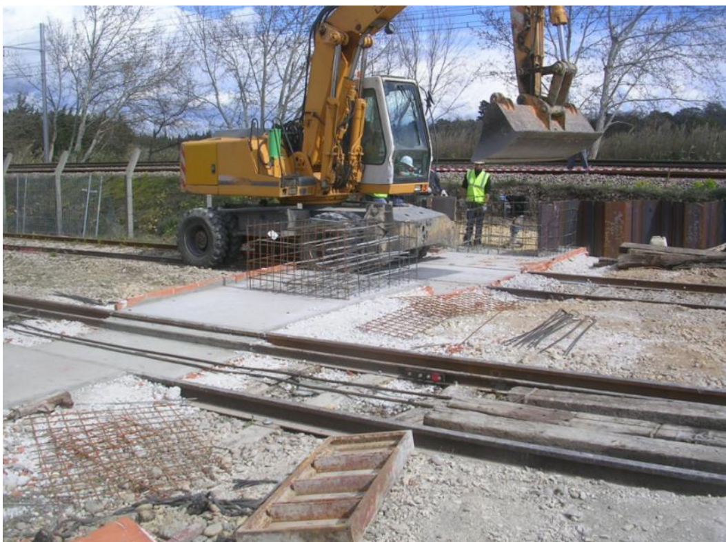
FIGURE 56 : REALISATION DES MASSIFS BETON VERTICAUX D'UN BATARDEAU AMOVIBLE SUR UNE VOIE FERREE A TARASCON (EGIS, 2014)
