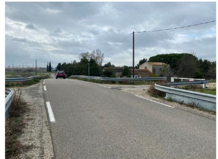
Exemple de rétablissement routier
