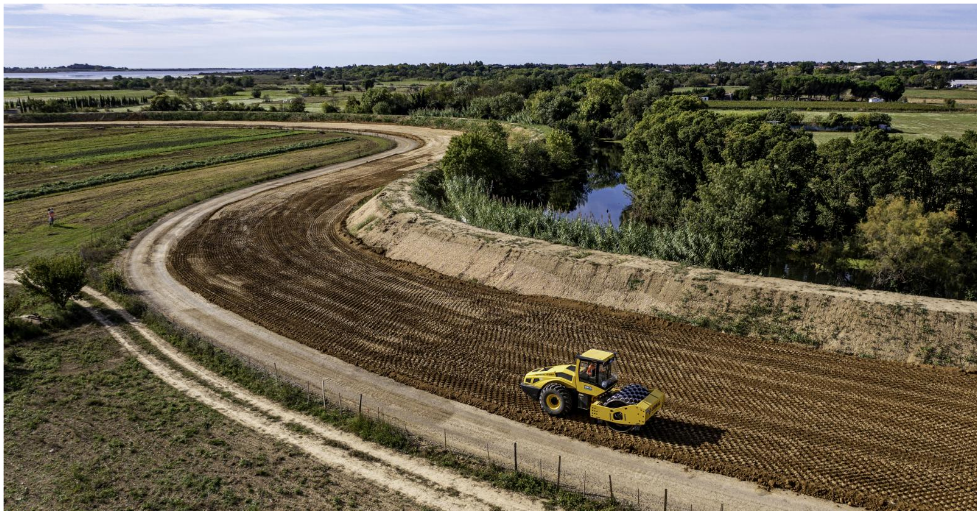
Exemple de construction de la nouvelle digue en recul
