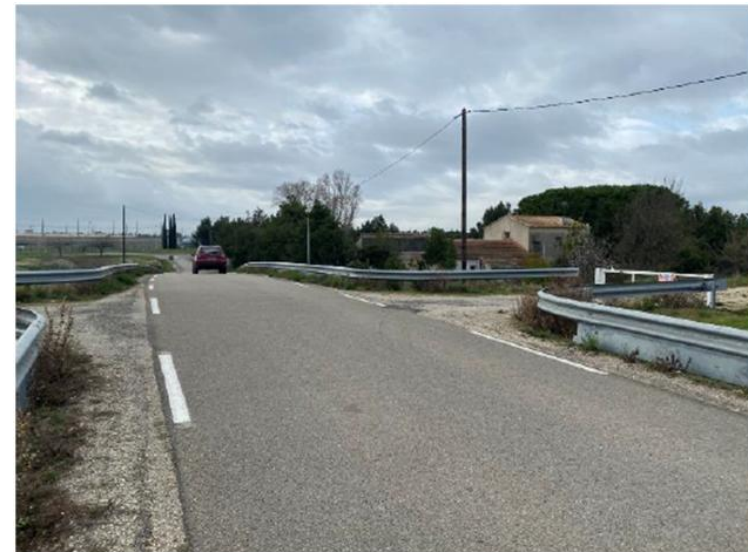
Exemple de rétablissement routier
