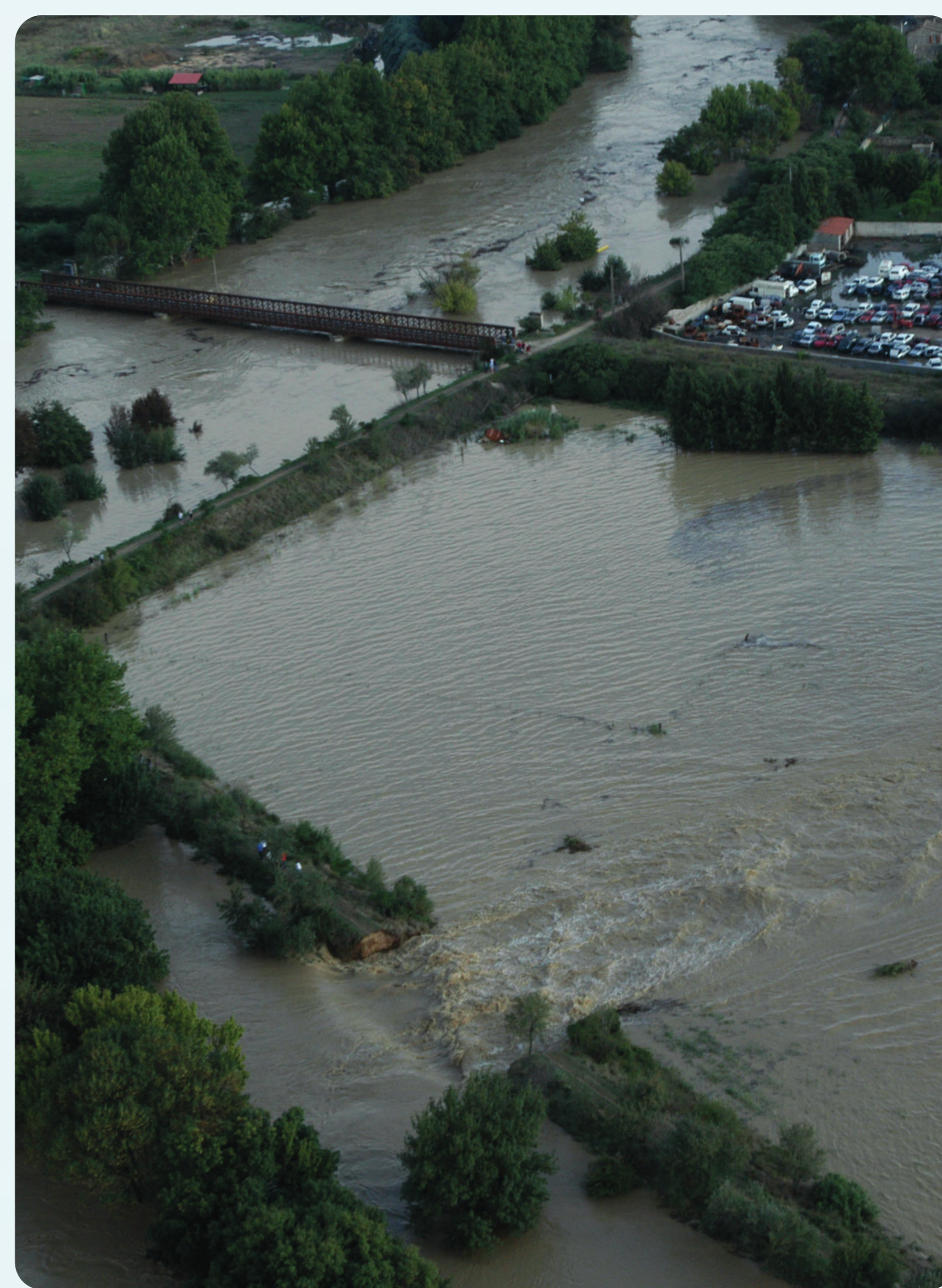
Marsillargues - Vue aérienne en amont de l'ancien pont
