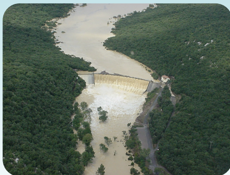
Barrage de la Rouviere sur le Creulon
