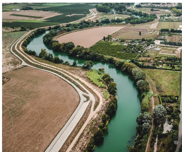
Digue de 1 er rang d'Aimargues confortée pour résister à la surverse
