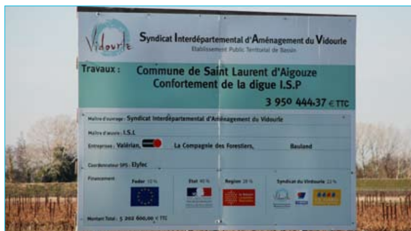
Panneau de Chantier
