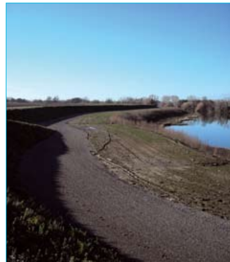
Digue de Saint Laurent d'Aigouze après travaux
