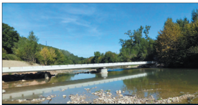
Fin du chantier de réhabilitation du seuil et passerelle de la Clotte
