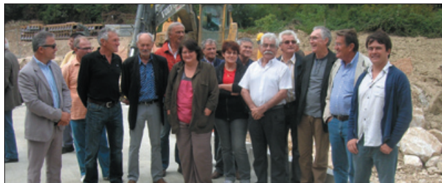
Les élus de la Communauté de Communes du Pays de Sommières en visite sur le chantier du Seuil de Runel
