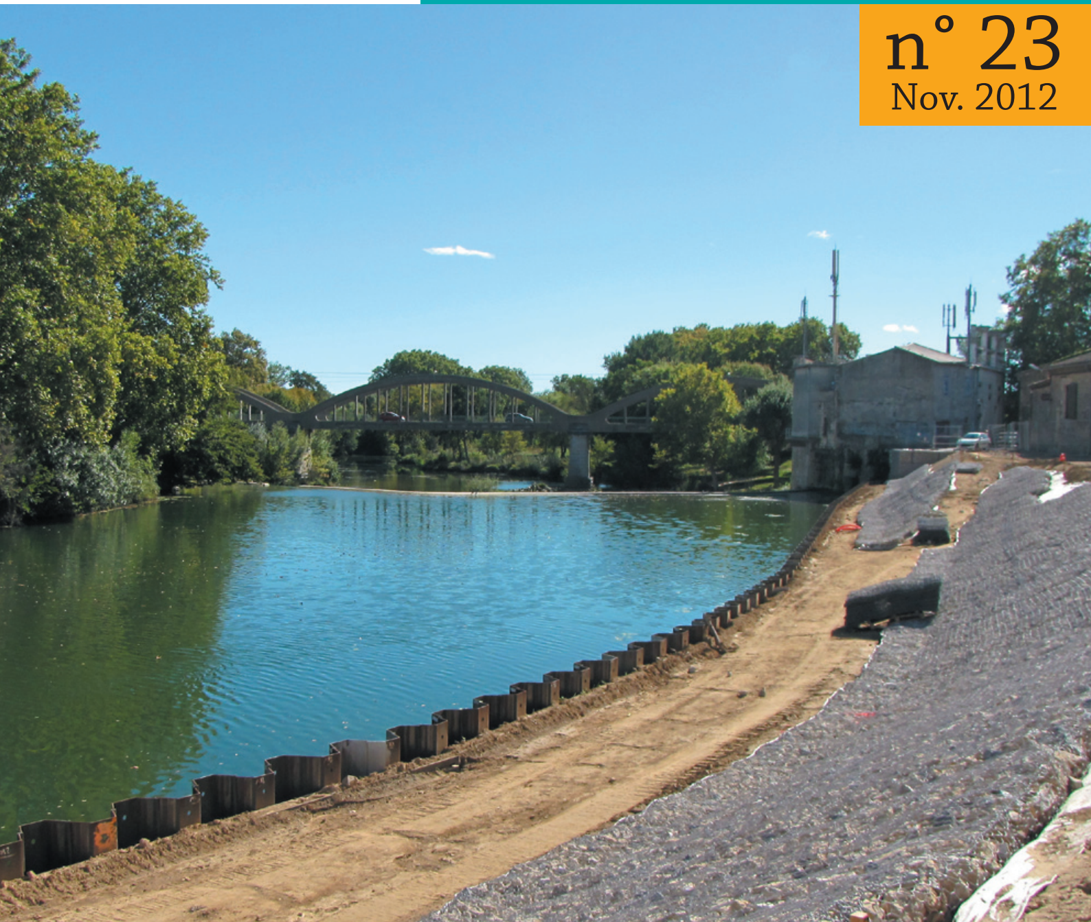
Digue de Marsillargues en cours de réalisation
