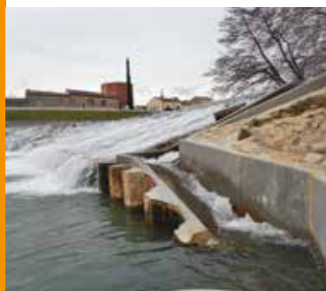
Passe à poissons de Marsillargues en fonctionnement
