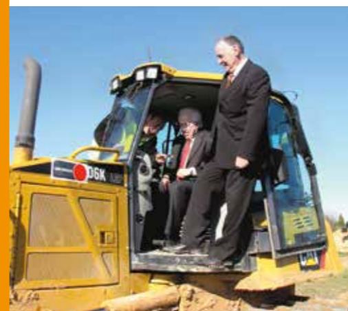
2009, les 20 ans du syndicat simultanément au lancement des travaux de la digue lunel
