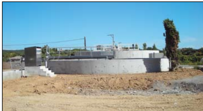
Nouvelle station d'épuration de Sauve
