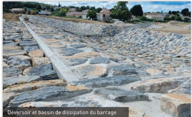
Déversoir et bassin de dissipation du barrage
