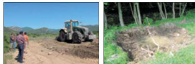
Lundi 23 mai 2011 : les élus du bassin du Vidourle En visite de chantier à St Hippolyte du Fort : site d'arrachage et site de concassage.
