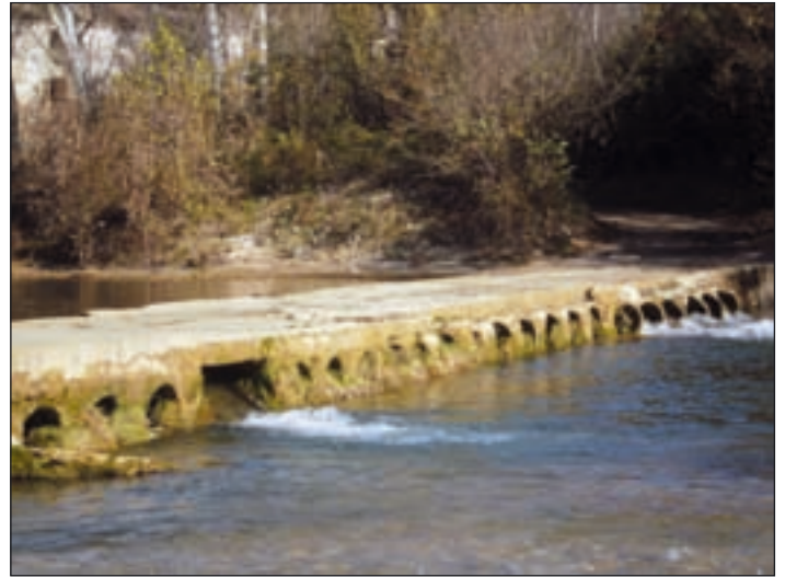
Passerelle de la clotte (futur chantier)
