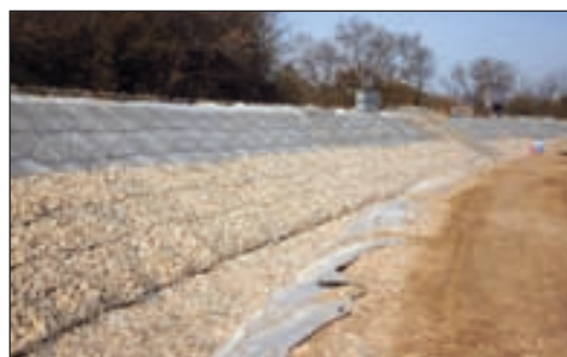
Chantier en cours, pose de matelas Reno
