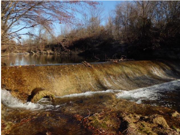
Seuil de l'ancien captage de Gailhan
